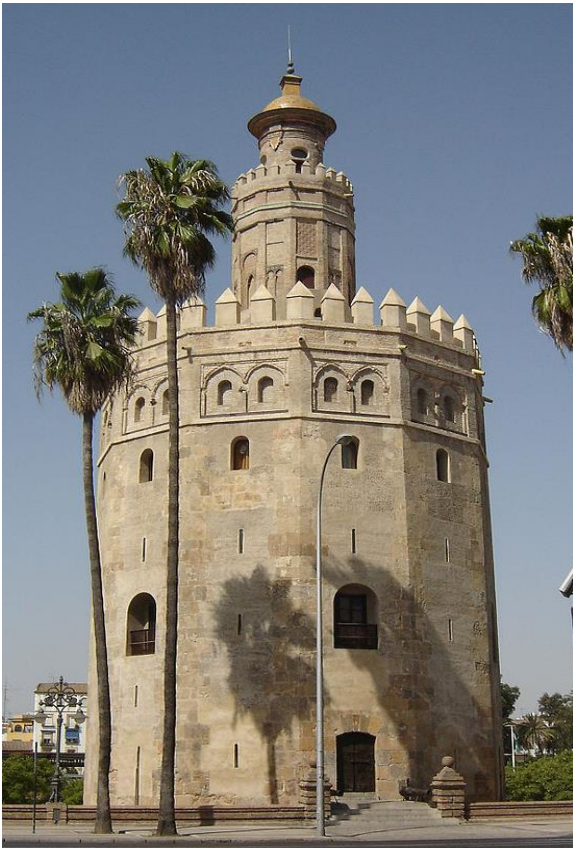
Torre del Oro (Sevilla).
