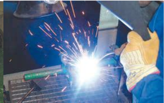
Figura 1.45. Soldadura MIG.
